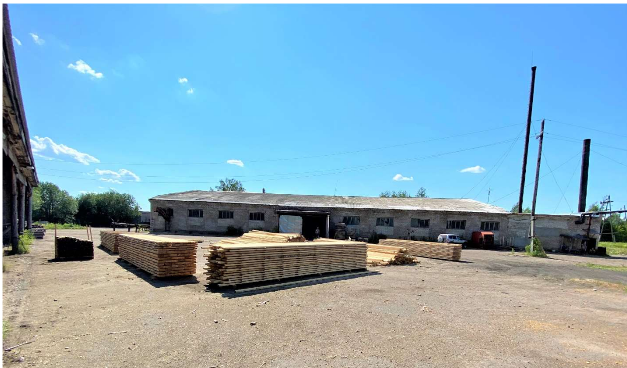
Здание Цеха и Котельной
