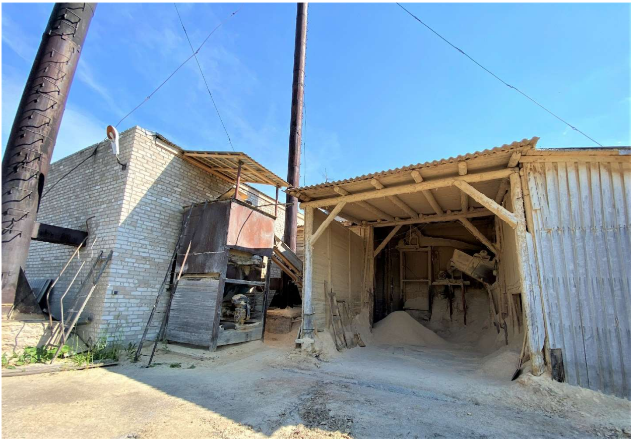
Склад опила / стружки и Бункер подачи в котельную
