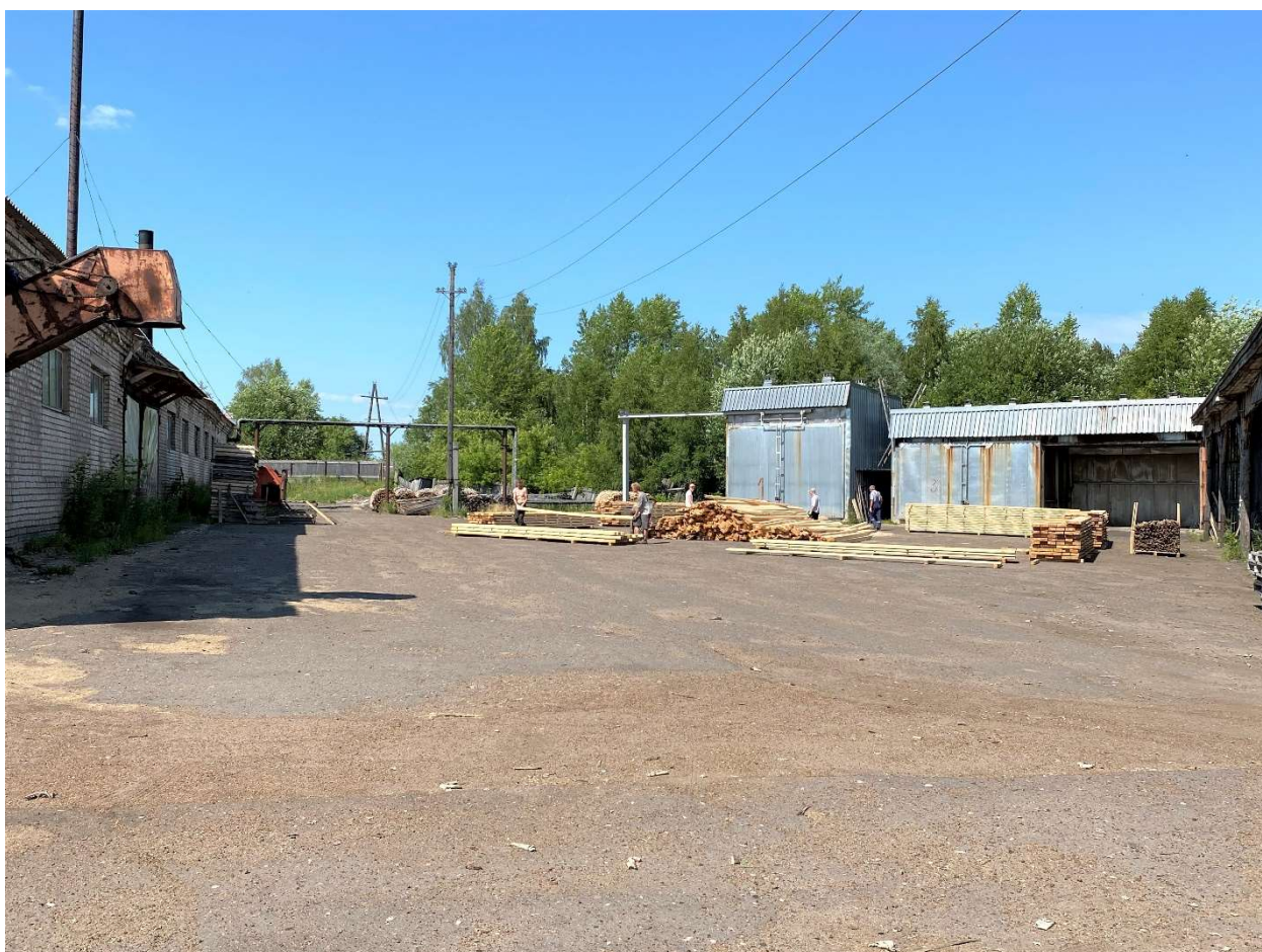
Площадка для раскладки пиломатериала и выдержки сушительных штабелей
